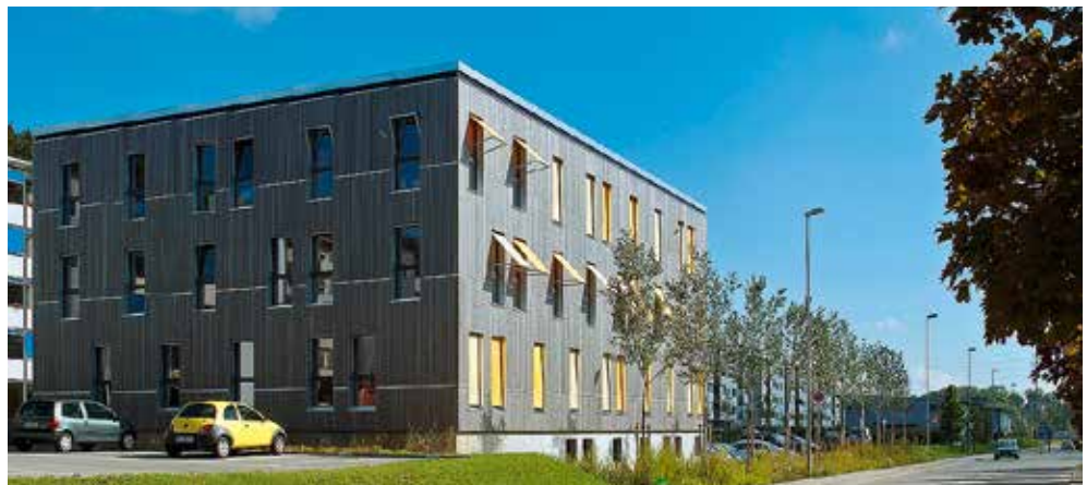
En haut, une réalisation du bureau d'architecture Lutz Associés, immeuble locatif Minergie P à Pensier (FR). Cette rénovation est issue du projet de recherche Coccum (rapporter des éléments préfabriqués en bois sur des façades existantes). Ci-dessus, le bâtiment Green Offices.
