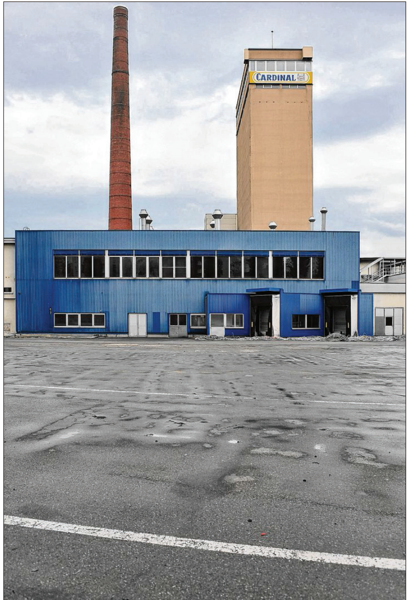
Ancien entrepôt de stockage de la Brasserie Cardinal, la «halle bleue» sera transformée et réaffectée en bureaux, laboratoires et ateliers d'ici à l'été 2015. Premier d'une longue série sur le parc technologique BlueFactory, ce chantier a été mis à l'enquête hier. ALAIN WICHTA
