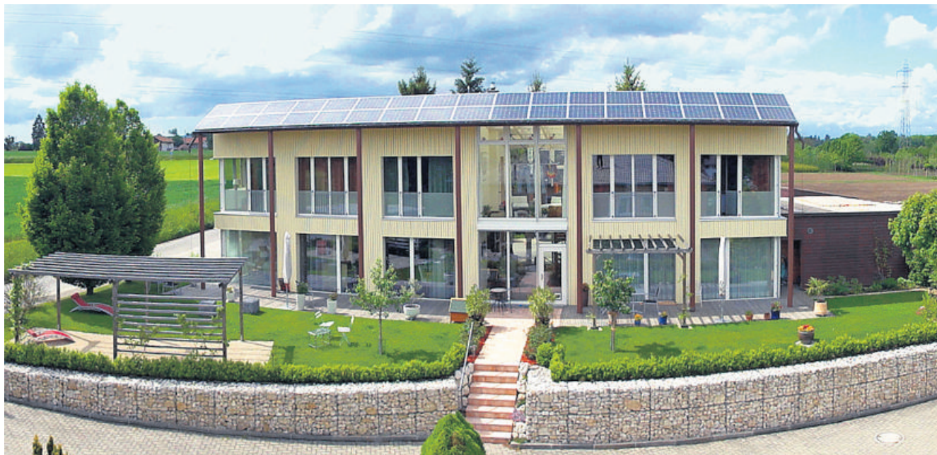
Cet habitat individuel de 182 m2 est chauffé à 63% par des panneaux solaires en toiture depuis juillet 2011.
